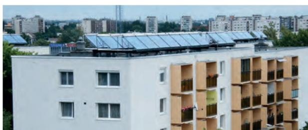
Desde 2011, a empresa Fehérep Kft. já reformou seis dos oito edifícios de quatro andares no bairro de Budapest XI a mando de associações de proprietários. As fachadas receberam um isolamento térmico com 10 cm de espessura. As modernas janelas da Fehér Ablak protegem com um coeficiente de transferência térmica de 1,3 W/m<sup>2</sup>K contra perda térmica. Aproximadamente 50% da água quente usada no edifício, é gerada atualmente por um módulo solar.
