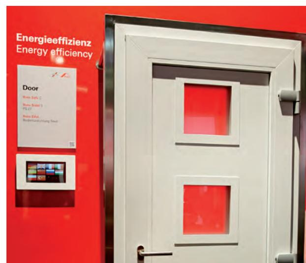
**Tendência de eficiência energética:** Aqui o frio permanece do lado de fora da porta – equipada com a soleira Roto Eifel 90 T, a vedação de piso da porta Roto Eifel Texel, as dobradiças para portas da Roto Solid S e um fecho de porta Door Safe C com jogo de travas que fecha a porta de entrada com segurança e vedação.
